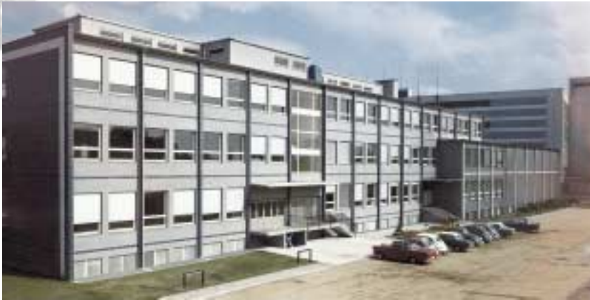
1966 wurde der zweite Bauabschnitt des DECHEMA-Instituts fertiggestellt.
